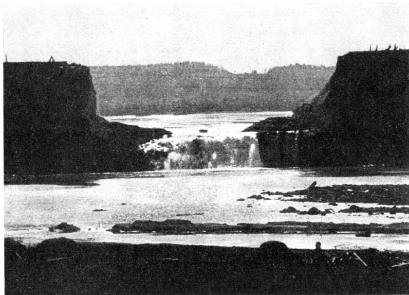
Abb. 4. Möhnetalsperre nach Zerstörung der Sperrmauer am 16. Mai 1943. (Fassungsvermögen 135 Millionen m 3 .)
