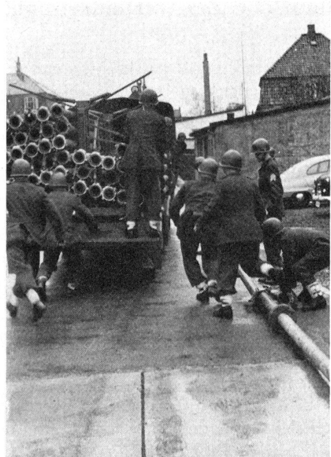
Die auf Spezialwagen mitgeführten Schnellkuppelungsrohren sind ein wertvoller Bestandteil der Ausrüstung. Von einer gut ausgebildeten Truppe können in sieben Minuten 420 m verlegt und an das Wasser angeschlossen werden.
