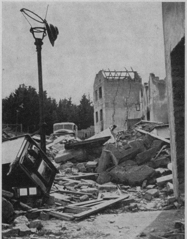
Vertrümmertes Strassenstück. Im Hintergrund das Fassadenhaus
