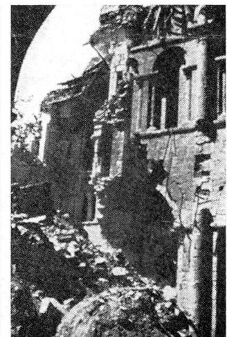
Frankreich: das bombardierte Querschiff der Kathedrale von Rouen (19. April 1944) wird wieder hergestellt (Holzgerüste für die Rekonstruktion der Spitzbogenarkaden)
