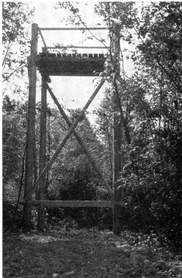
La tour d'exercice en simple construction de bois
