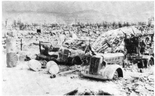
Abb. 4. Hiroshima, Zone der totalen Zerstörung
