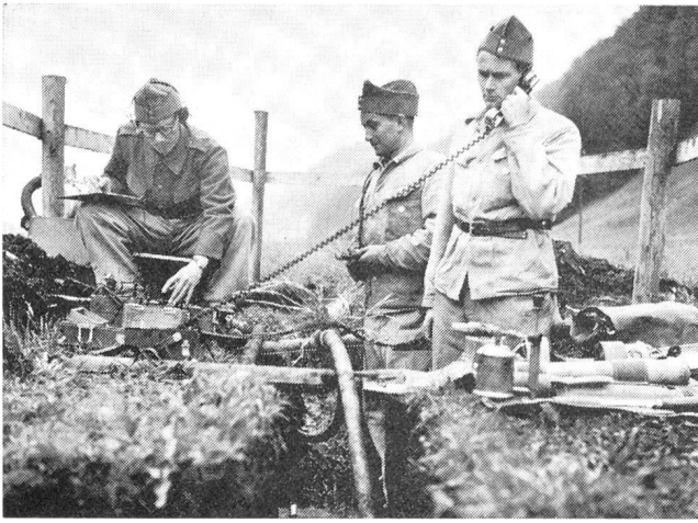
TT-Betriebsgruppe bei der Reparatur eines Kabels
