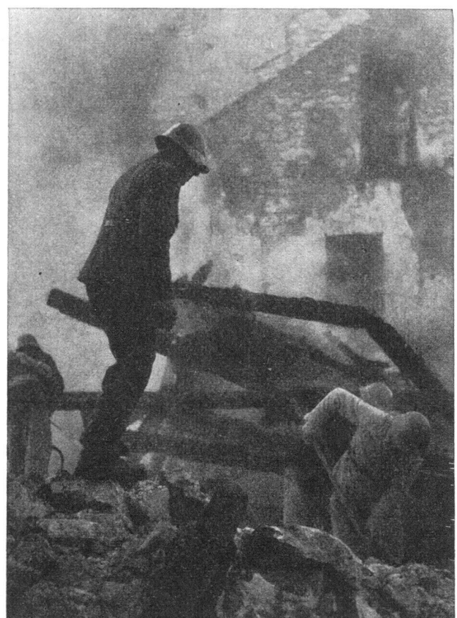
Befreiung von Verschütteten
