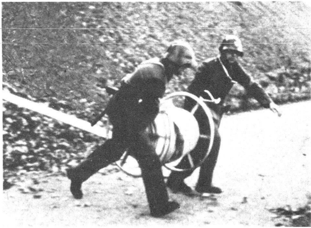
Auslegen der Leitung
