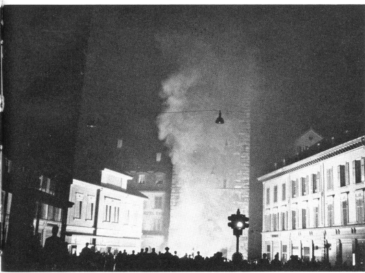
Stadtzentrum und Schlossbergplatz liegen im schwerbetroffenen Katastrophengebiet
