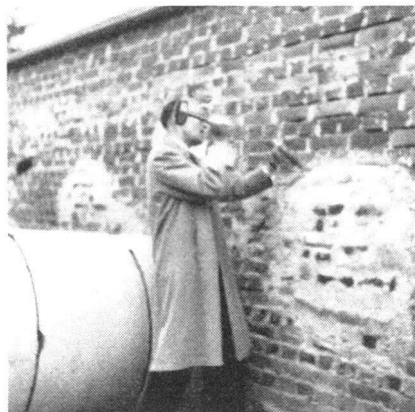
An dieser Mauer werden in der Praxis Mauerdurchbrüche geübt.
