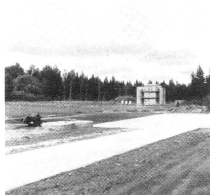
Übungsgelände des ABC-Dienstes; im Hintergrund das grosse Brandhaus.
