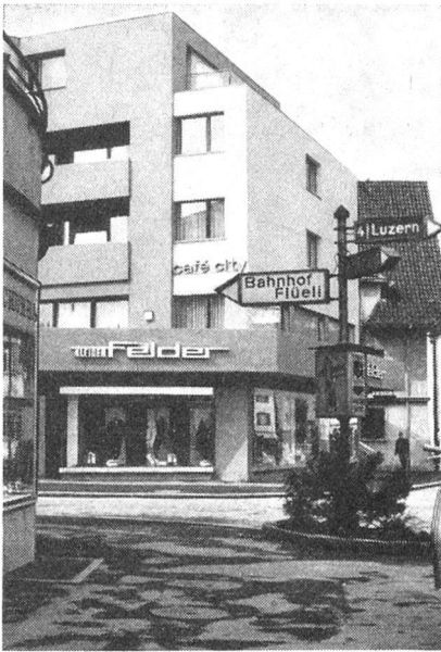
Das ist das neue und moderne Geschäftshaus Felder in Sarnen, das ringsum, wie unser Bild zeigt, grosse Risse aufweist und Schäden erlitt, die kaum ganz repariert werden können. Gut gehalten haben sich die Schutzräume dieses Hauses, die dem Beben widerstanden.
