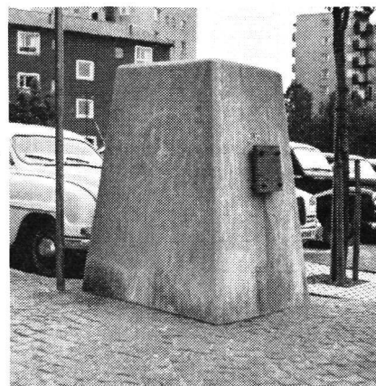
Trümmersicherer Ausstieg aus einem Schutzraum in Vällingby.
