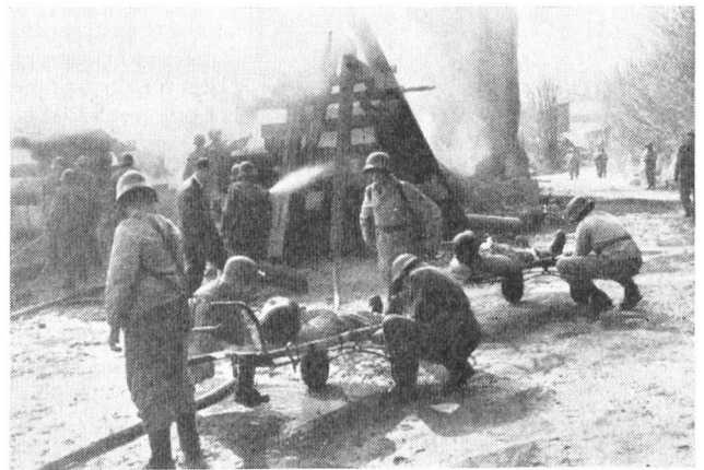
Im Rahmen einer Einsatzdemonstration am Abbruchobjekt des Schlosses Chartreuse in Hilterfingen hatten die Luftschutztruppen Gelegenheit, ihren Beitrag zum Schutze der Zivilbevölkerung eindrücklich unter Beweis zu stellen. (Photo SBZ)
