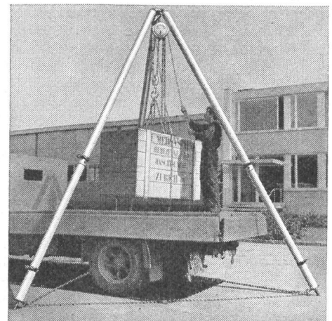
◀◀ «Meili-Deckenstütze» ganz aus Stahl (⊕ Patent), ist feuerfest, kann jederzeit durch Anwesende nachgespannt werden und fällt nicht um. Keine andere Metall- oder Holzstütze bietet dieselbe grosse Sicherheit. Je nach dem verwendeten Rohr kann die Tragfähigkeit 50 t überschreiten. EMPA-Attest verlangen.
