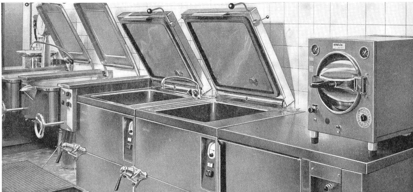
Teilansicht Kantine Geigy – Burckhardt Architekten SIA
