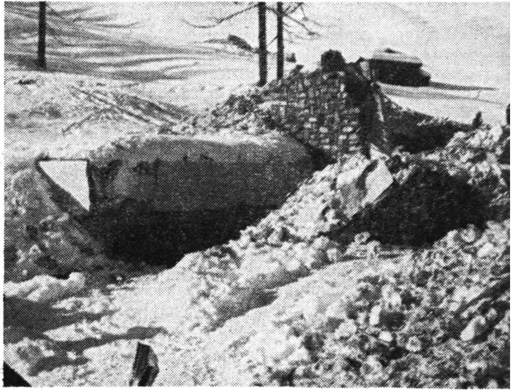
Obergeschoss weggefegt, zwei Tote; Untergeschoss inklusive Schutzraum intakt Etage supérieur déblayé, deux morts; sous-sol, y compris abri, intact
