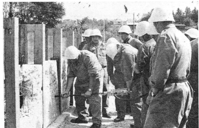
Einsatz des Bohrhammers an einem Betonelement. Um den Unfallgefahren zu begegnen und trotzdem die Hände zu schützen, wird der Bohrhammer mit zwei Plasticrohren versehen und auf die Handschuhe verzichtet
