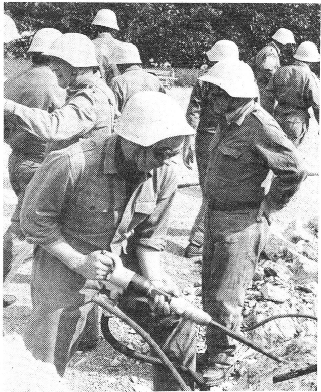
Einsatz pneumatischer Werkzeuge am Rande der Trümmerpiste
