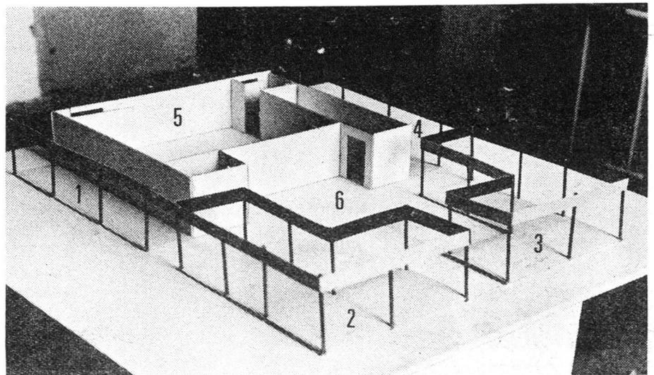
Nachdem der Grundriss für die Ausstellung im Comptoir feststand, wurde ein massstabgerechtes Modell angefertigt, an welchem die Proportionen der dekorativen Elemente bestimmt werden konnten. Die Ziffern bedeuten: 1 Material der Kriegsfeuerwehr, 2 Operationsgruppe und Pflegematerial, 3 Material des Pionierdienstes, 4 Uebermittlungsgeräte, 5 Kinoraum, 6 Informationszentrum.
