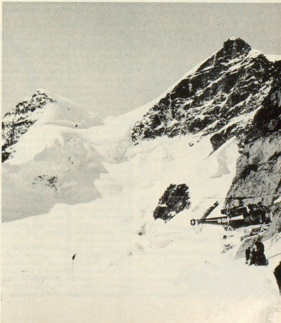
Helikopter im Schwebeflug zur Aufnahme von Material
