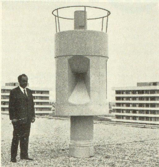
Modernste und lautstärkste Zivilschutz-Sirenen mit eigenem Dieselaggregat, Kompressor und Reserve-Luftbehälter
