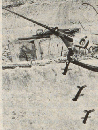
Abb. 29. Drei Bohrlöcher in armiertem Beton
