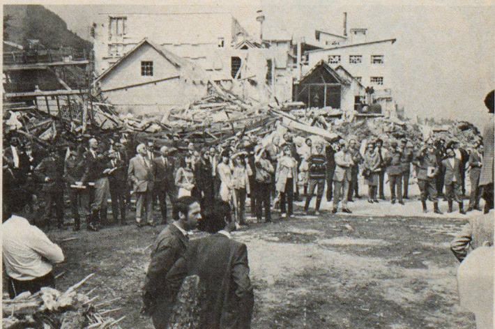
Abb. 3. Blick in die Trümmerpiste
