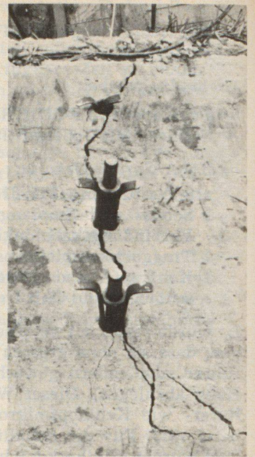
Abb. 30. Eingedrungene Spaltkeile. Zum Trennen der Armierungseisen wird nur das Schneideisen eingesetzt
