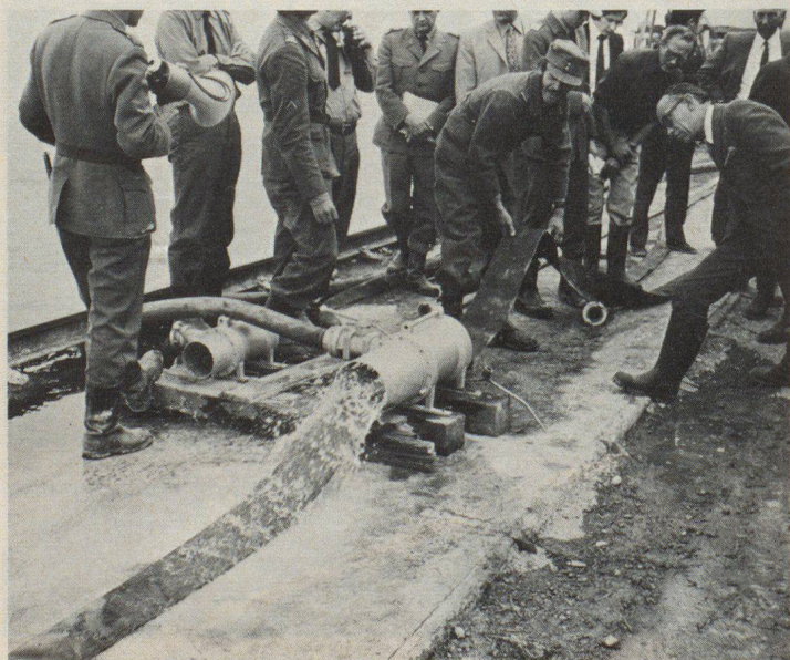
Fig. 17. Appareil lave-tuyau des troupes de protection aérienne
