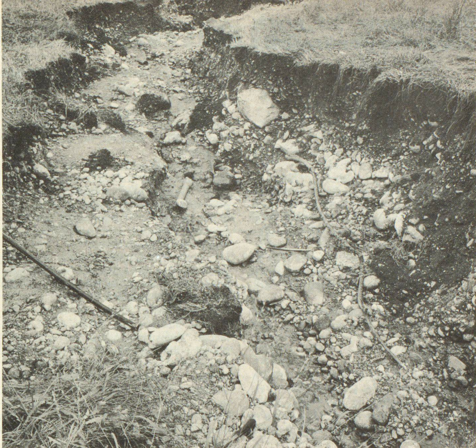
Ausgespülte Geländemulde im Schadengebiet vom Eichenried
