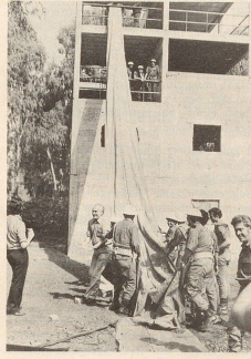
Neuer Rutschschlauch des israelischen Zivilschutzes zur Rettung von Personen in oberen Stockwerken. Bild aus dem Instruktionzentrum für Kaderausbildung der HAGA im Raum Tel Aviv
