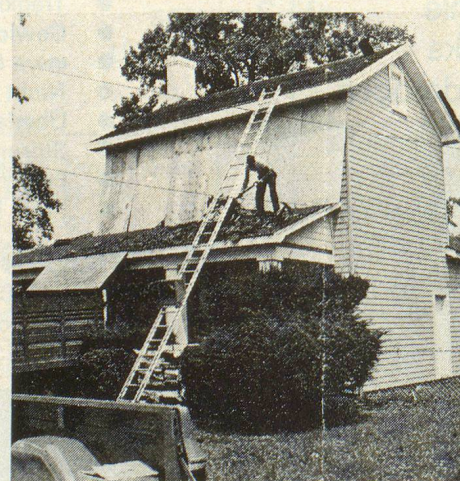
4 Die alten Ziegel oder Schindeln werden vom Dach geschaufelt. Probleme gibt der Mangel an Arbeitskräften und Material auf
