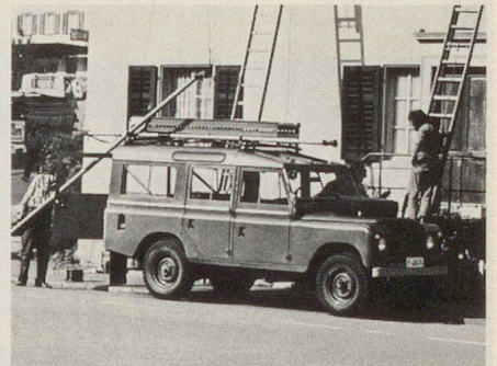
Pose de lignes téléphoniques ou câbles aériens
