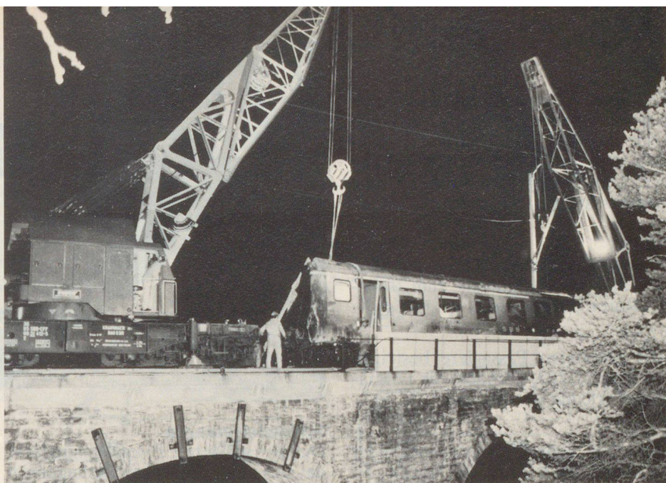
Der 25-t-Kran links und der 32-t-Kran der SBB rechts bei der Bergung des 19 t schweren grösseren Teils des Personenwagens. Foto BLS
