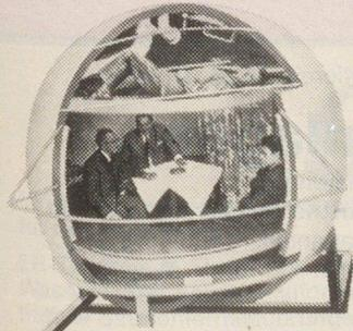
aus Stahlbeton-Fertigteilen, typengeprüft und genehmigt. Sicherheit gegen Luftdruckstösse S3, atomare, auch Neutronenstrahlungen, chemische und biologische Kampfstoffe. Einbauzeit: 1 Tag.
