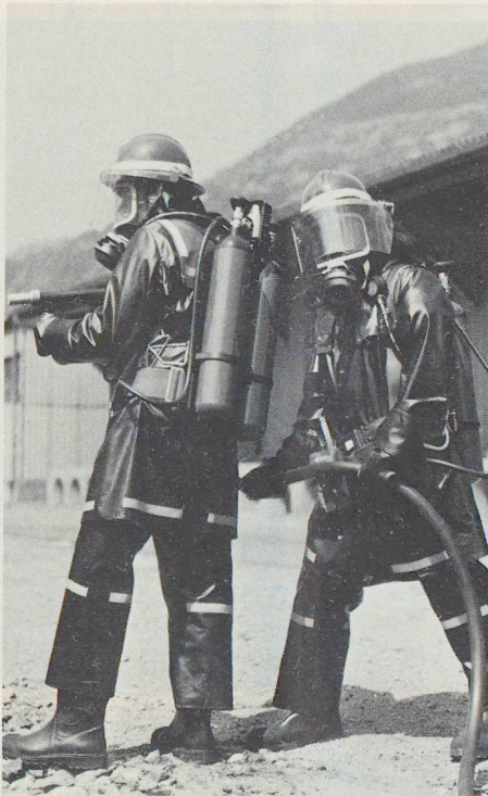
Abdichten von Lecks an einer Heizölzisterne
