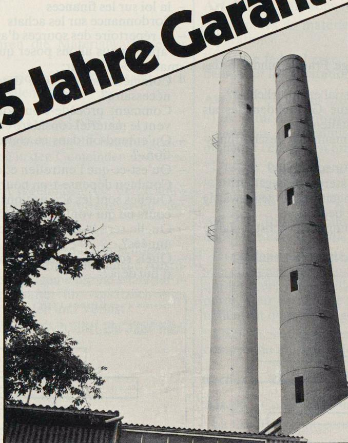
In solchen Türmen wird bei Meister die Innengummierung der Schläuche aufgetragen und vulkanisiert. Das Verfahren ist aufwendig, bringt aber entscheidende Qualitätsvorteile.
