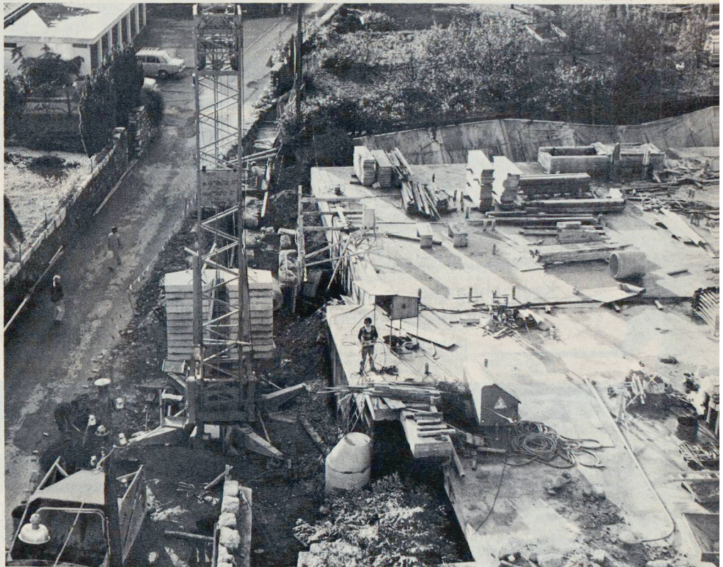
Vue aérienne du chantier.
