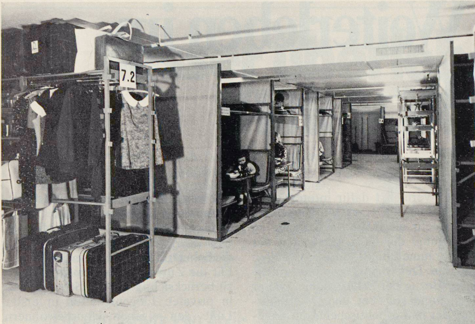
Blick in einen mit Kojen eingerichteten öffentlichen Schutzraum.
