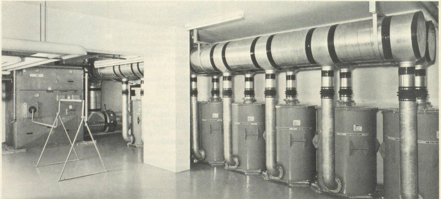
Ventilationsraum einer geschützten Operationsstelle. Filterluftmenge 4'800 m<sup>3</sup>/h - Frischluftmenge 9'600 m<sup>3</sup>/h.
