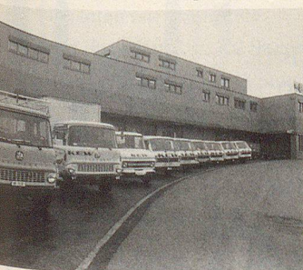
Ansicht Clanderstrasse; Servicewagen.
