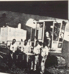
Spätestens für den ersten öffentlichen Schutzraum im Bau des Zivilschutz-Zentrums der Gemeinde Rüderswil (Präsident der Zivilschutzkommission), Simon Gerber (Zivilschutzstellenleiter), Walter Lüssi (Projektleiter), Fritz Grunder (Grundigentümer) und im Bagger sitzt Gemeindepresident Fritz Grunder. Bild: Hans Schmid, Bülach
