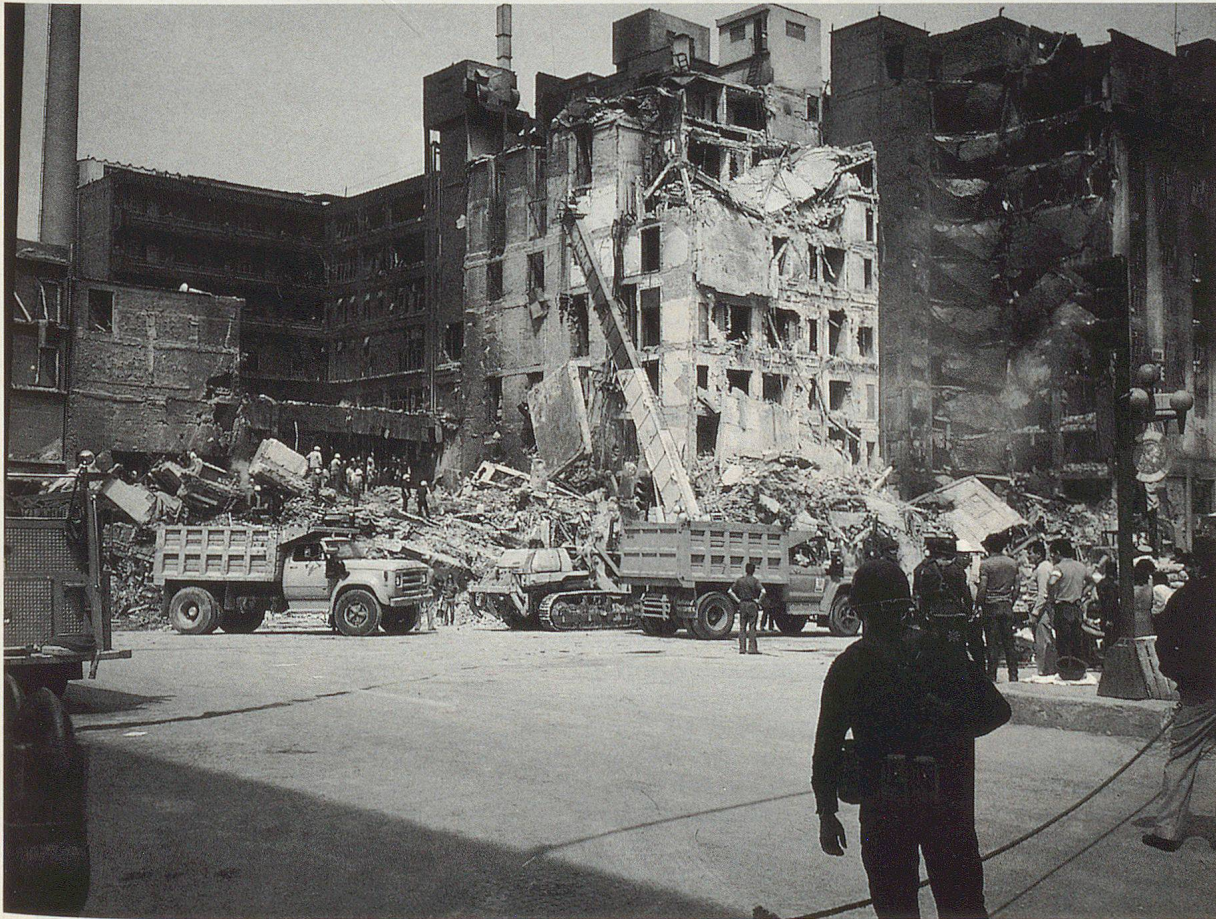
Zerstörung – soweit das Auge reicht.
