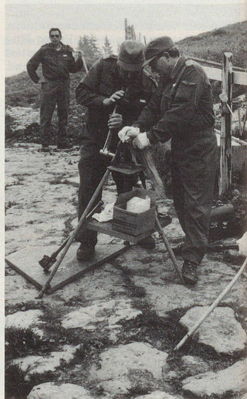
Zürcher Zivilschützer packen im Schwyzerland zu: Zwischen Ober- und Mittel-Schrot entsteht eine neue Wasserleitung von 200 Metern Länge.
