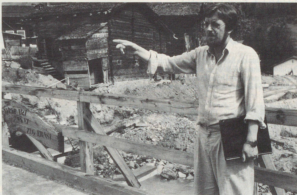
Die Unwetterskatastrophe vom 24. August 1987 hatte in Münster (VS) auch an Privathäusern grosse Schäden angerichtet. Gemeindepräsident Silvan Jergen, auf einer vom Militär errichteten Notbrücke stehend, orientiert über den Wiederaufbau.
