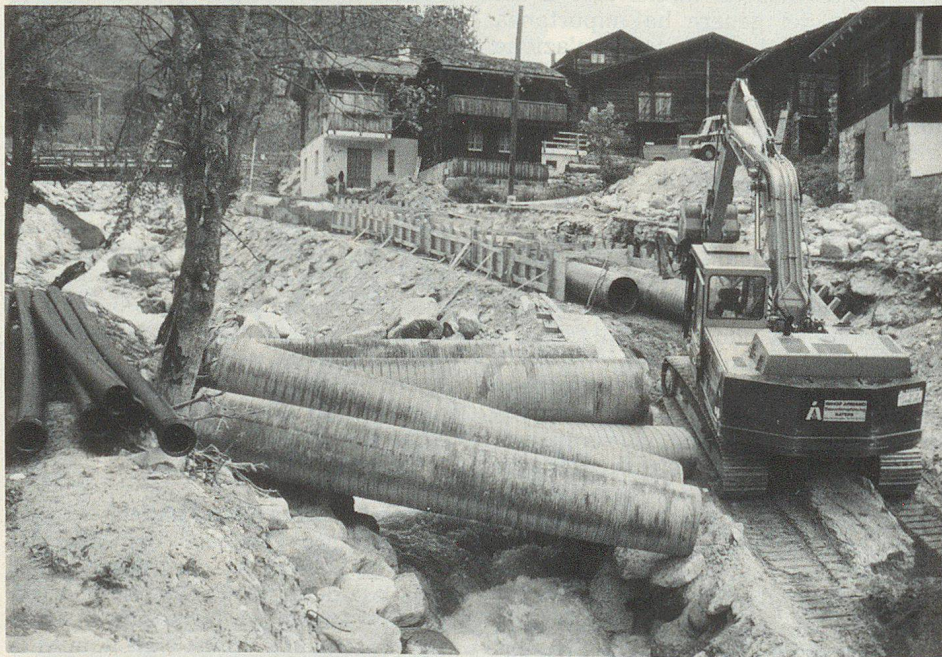
Nach dem Katastrophenunwetter vom 24. August 1987 war das Bett des Münstigerbaches in Münster (VS) völlig mit Gesteinsblöcken zugeschottert. Während schwere Baumaschinen ein neues Bachbett graben, wird das Wasser durch Röhren umgeleitet.
