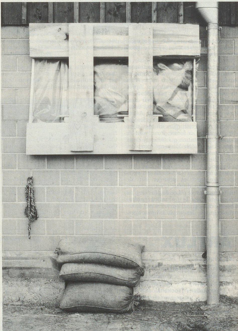
Con costruzioni semplici (sacchi di sabbia, mattoni, legno, plastica, ecc.) si provvede a chiudere le aperture della stalla. Con ciò si ottiene un'aerazione indiretta della stalla attraverso l'aia e gli animali sono meglio protetti contro le radiazioni e le schegge.
