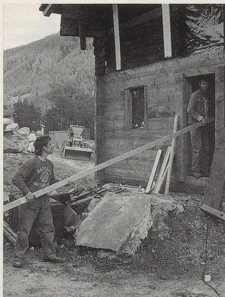
Beim Wiederaufbau der beschädigten Häuser packen die Einwohner tatkräftig mit an.
