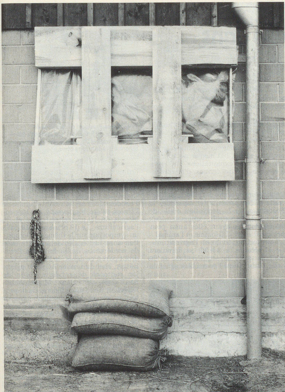
Mit einfachen Konstruktionen (Sandsäcke, Backsteine, Holz, Plastik usw.) werden Stallöffnungen verschlossen. Damit kann eine indirekte Stallbelüftung über das Tenn erreicht werden, und die Nutztiere werden besser vor Bestrahlung und Splintern geschützt.
