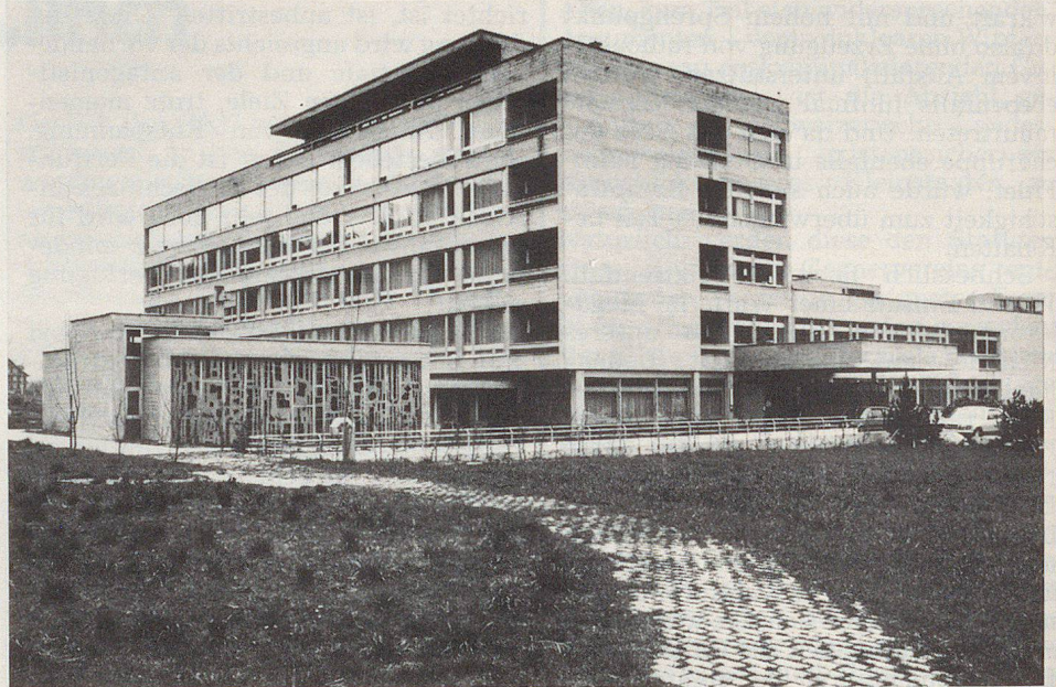
Unmittelbar neben dem Haupteingang zum Kantonsspital Nidwalden in Stans befindet sich die Eingangsrampe zur geschützten Operationsstelle und zum Kulturgüterschutzraum
