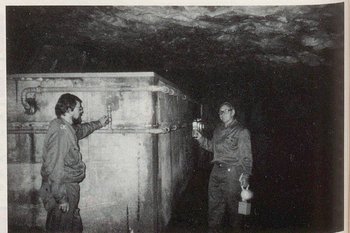
In den Gewölben zwischen Kommandoposten und Felsen.
