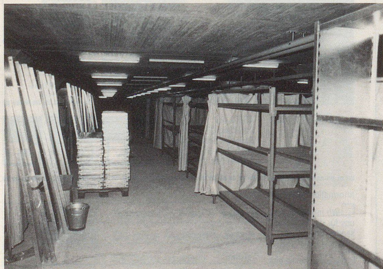
Les installations des lits au 4 e sous-sol.
