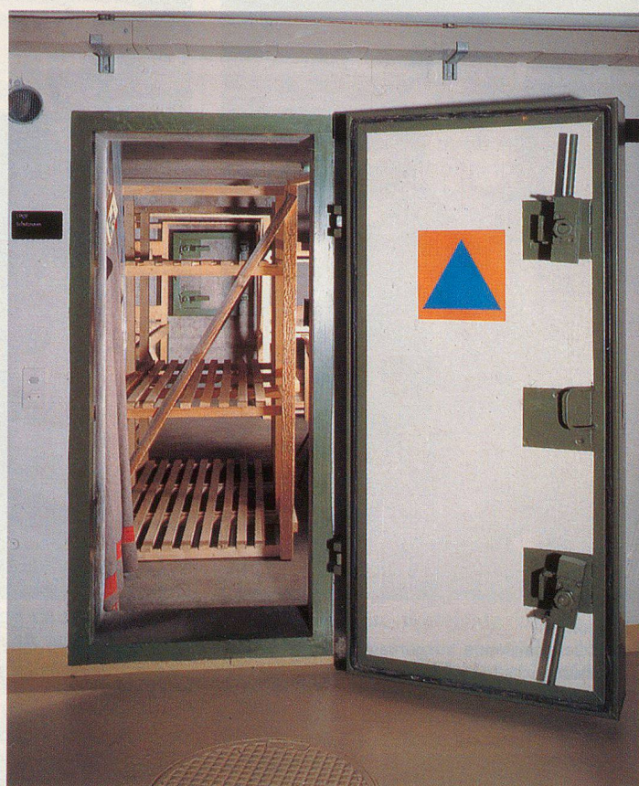
Figure 3 Signalisation extérieure et intérieure (signe distinctif de la protection civile, en papier de 30x30 cm) apposée sur les portes d'entrée (portes blindées) d'abris obligatoires (chi. 231, 1er al.).
