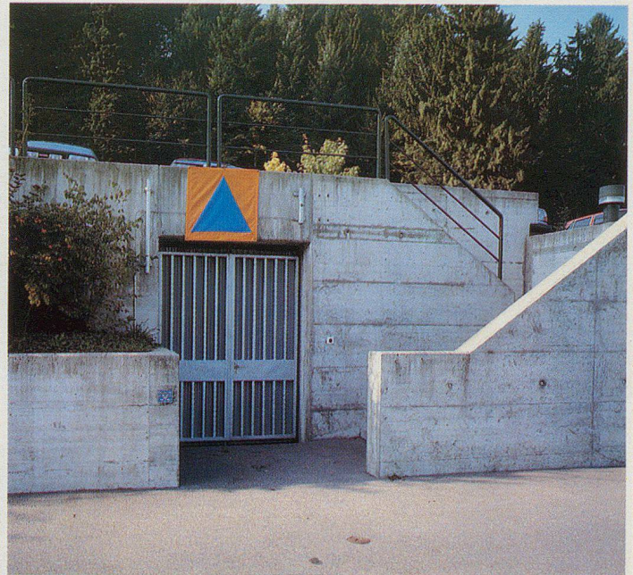
Figure 4 Exemples de signalisation extérieure (signe distinctif de la protection civile, en tissu de 80x80 cm) de constructions isolées des organismes de protection (PC, postes d'attente) et d'abris publics ainsi que d'ouvrages combinés dépourvus de partie réservée au service sanitaire (chi. 232, 2e et 3e al.).
