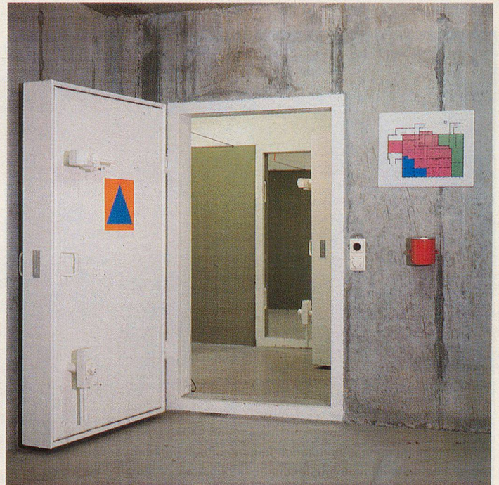
Figure 5 Les constructions de protection mentionnées dans la légende de la figure 4 doivent encore être pourvues du signe distinctif de la protection civile (signe distinctif en papier de 30x30 cm) apposé, à l'extérieur comme à l'intérieur, sur la(les) porte(s) blindée(s) (ou sur la porte d'entrée des constructions et abris de fortune) (chi. 231, 1er et 3e al.).
