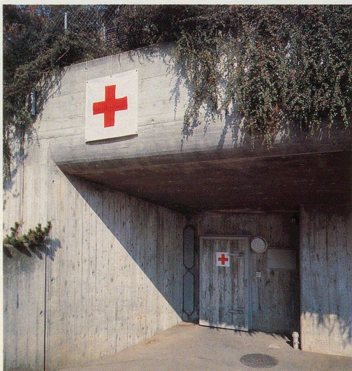
Abbildung 7 Zusätzlich werden die in Abbildung 6 erwähnten Anlagen aussen und innen auf der Panzertüre mit dem Rot-Kreuz-Zeichen gekennzeichnet, Ziffer 231 Abs. 1 und 3.
