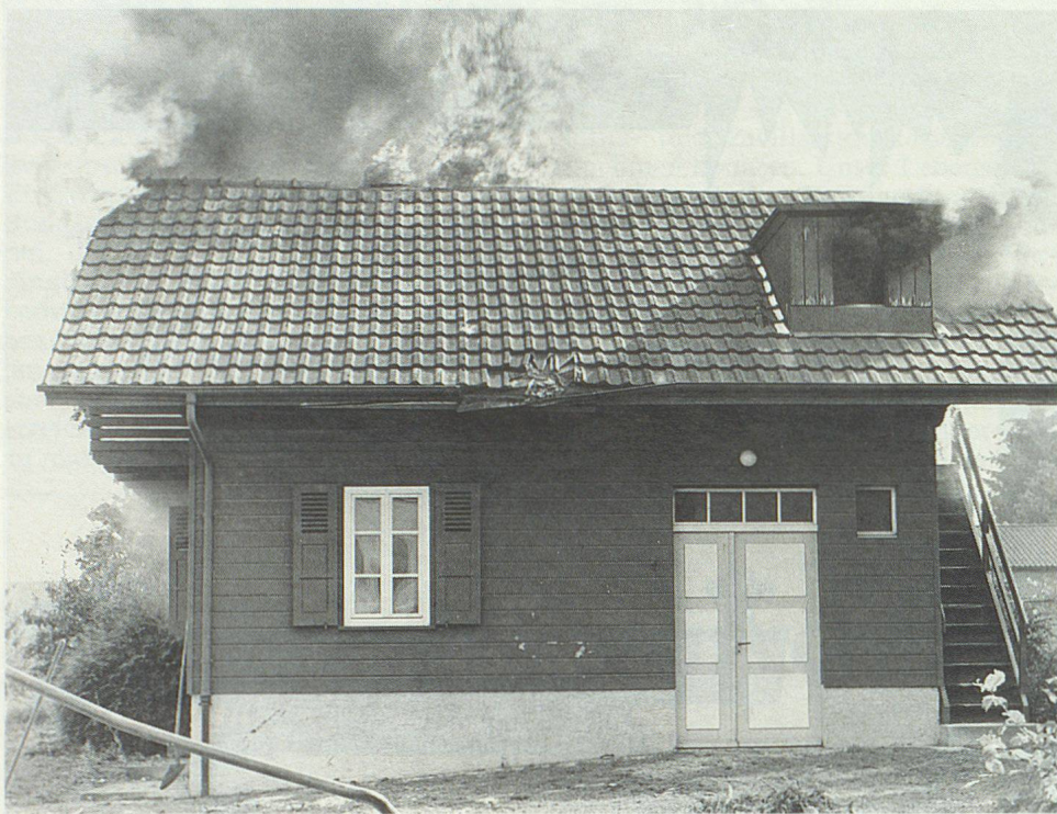
Ein Gebäude ist in Brand geraten.
