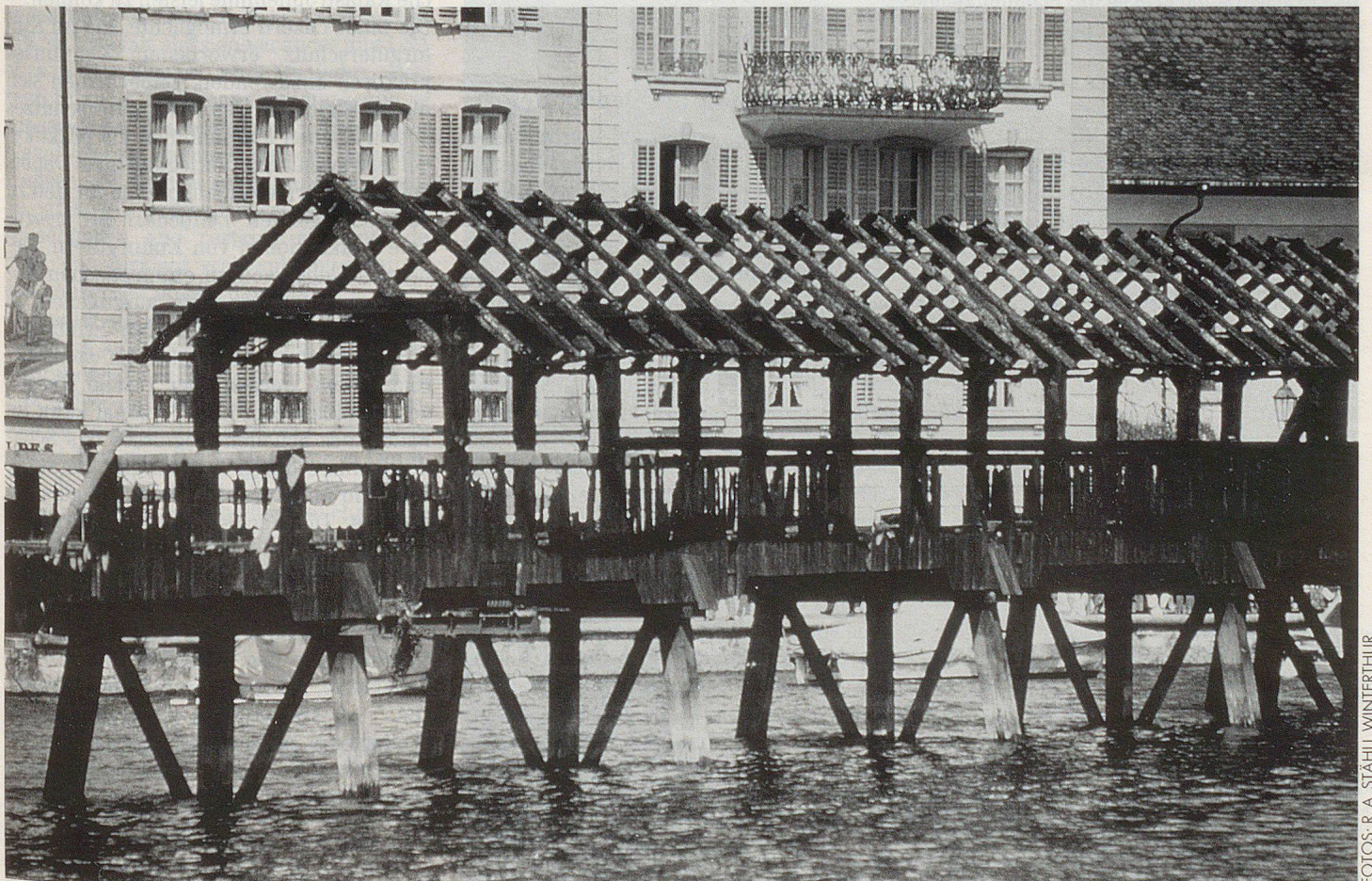
Die Kapellbrücke nach dem Brand.
