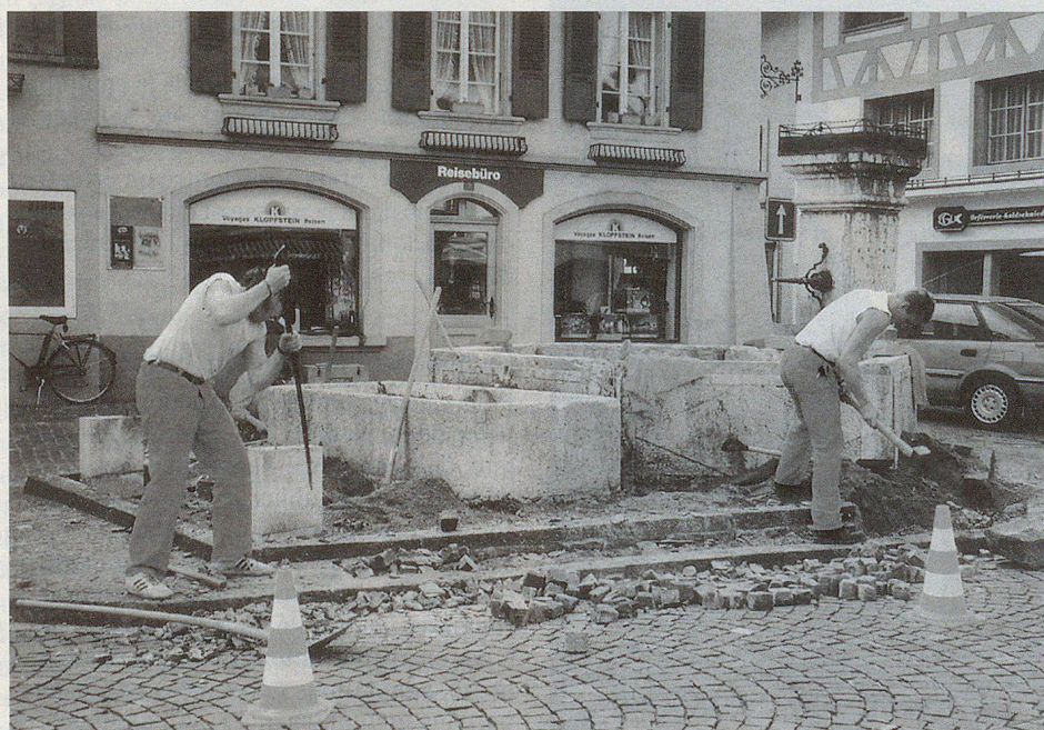
Sanierung des Rübenlochbrunnens im oberen Städtchen.
