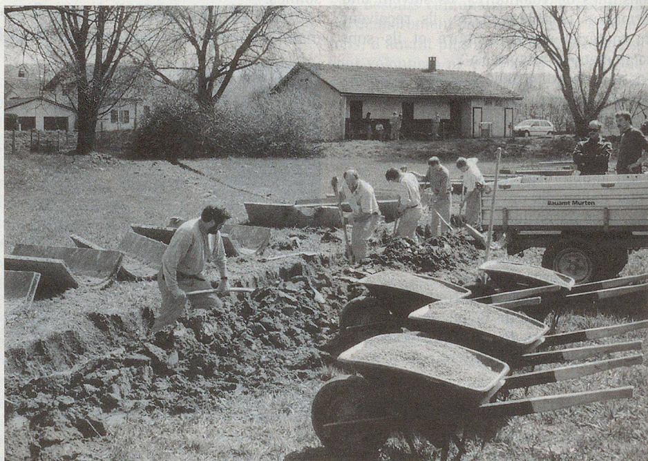
Sanierung Entwässerungskanal Pra-Pury.
