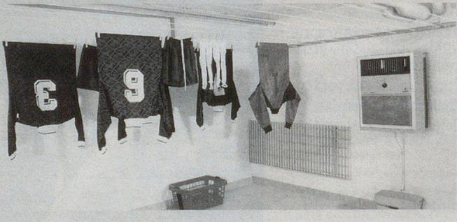
Mit den Bora-Wäschetrocknern von Roth-Kippe ist das kein Problem. Die Trockner entziehen der Luft Feuchtigkeit und beschleunigen damit den Trocknungsvorgang enorm. So trocknet die Wäsche in kürzester Zeit, ohne Schaden zu nehmen. Dies erst noch mit einem **wesentlich geringeren Stromverbrauch als zum Beispiel bei der Trocknung mit dem Tumbler**. Und der weitere Nutzen; auch feuchte Kellerräume gehören der Vergangenheit an.
