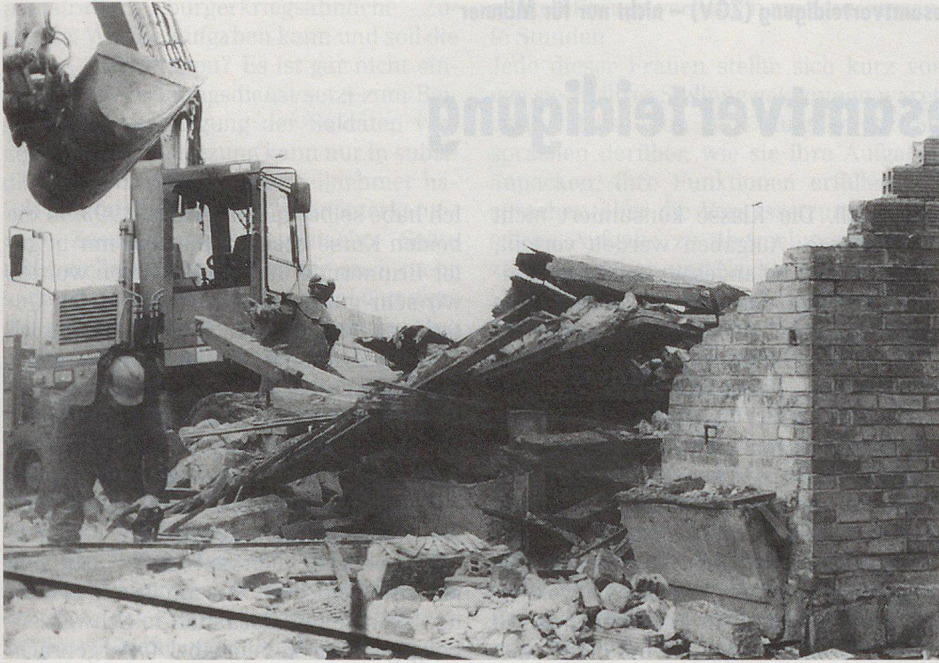
Trümmerhaufen beim Abbruch eines Hausanbaus in Schenkon.
