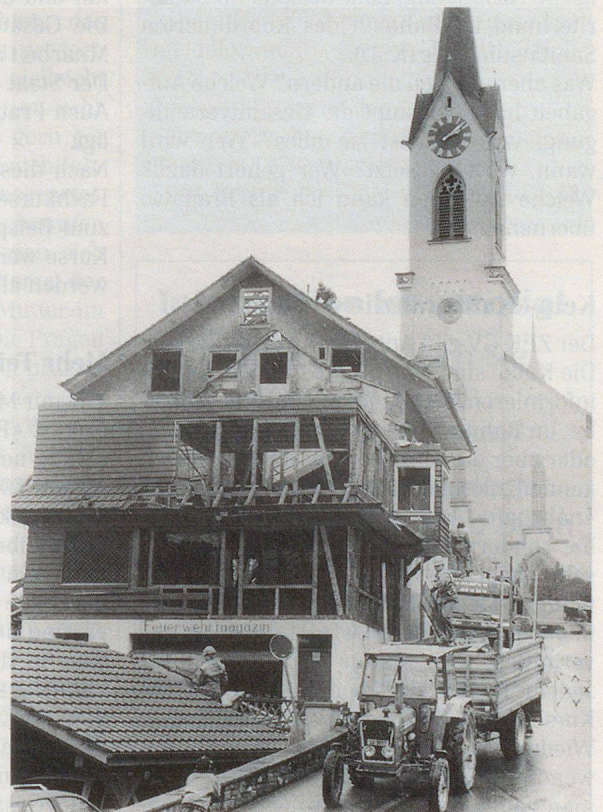
In Nottwil muss das alte Vikariatshaus, das auch als Feuerwehrlokal diente, einem Neubau weichen.
