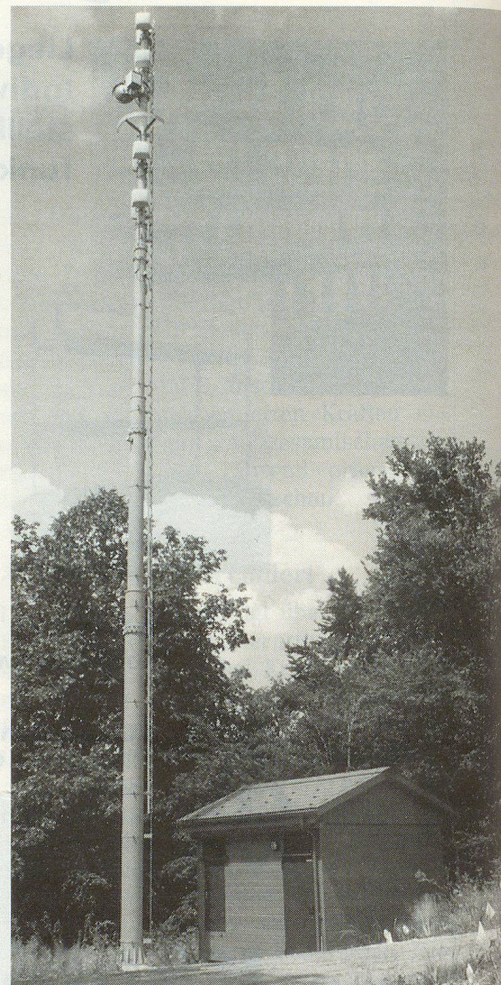
Une des quelque 1500 stations de base qui permettent l'utilisation du Natel D en Suisse. La station de base de Densbüren AG couvre une zone de 5 à 7 kilomètres de diamètre.
