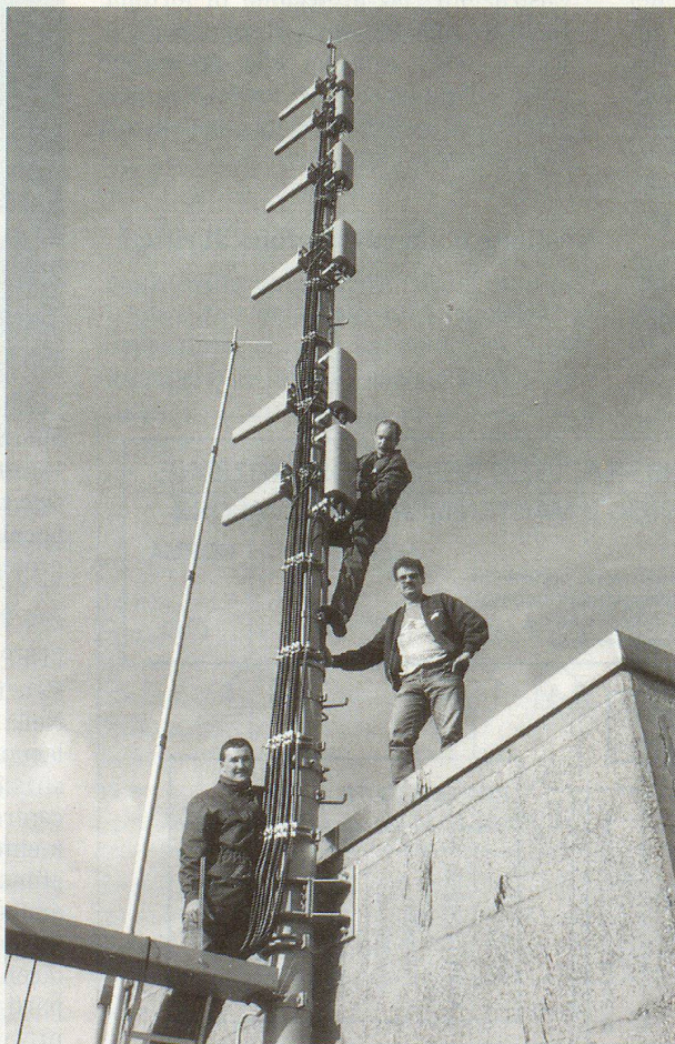
Mobilcom-Spezialisten beim Aufbau einer neuen Natel-D-Basisstation. Diese versorgt ein Gebiet von 5 bis 7 Kilometern Durchmesser mit dem beliebten Mobiltelefon-Dienst.
