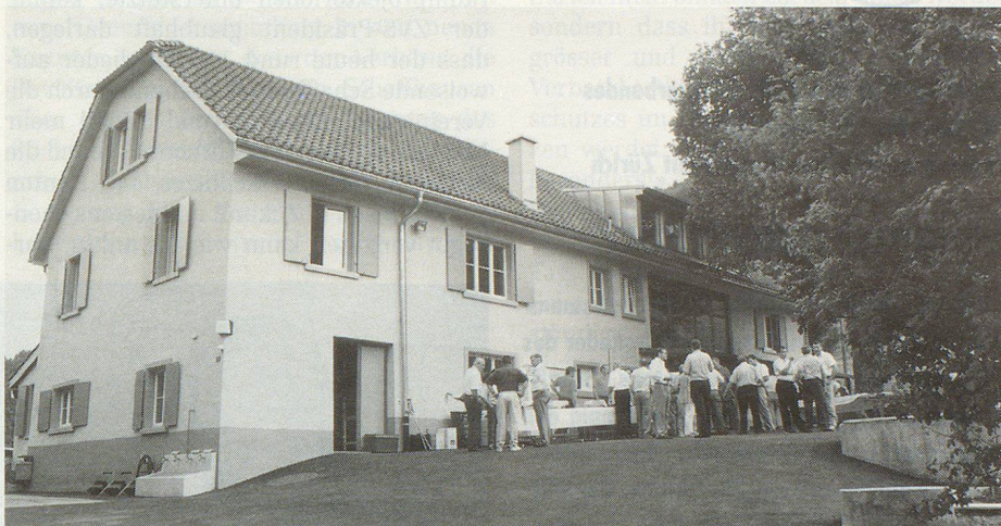
Das umgebaute Zivilschutz-Ausbildungszentrum «Fraurütti» in Langenbruck.
